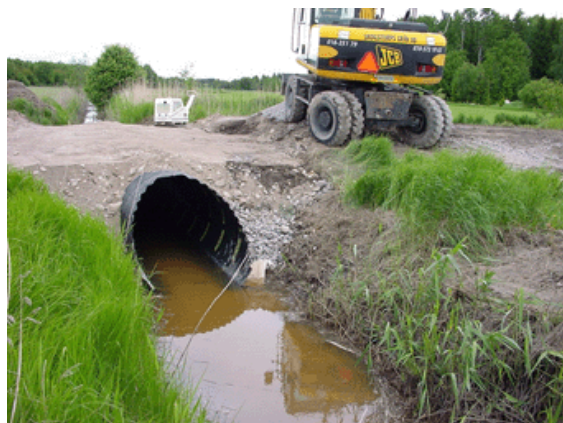
Figur 2. Utbyte av vägtrumma. Trummans läge och utformning kan påverka möjligheterna för fiskar och andra djur att röra sig längs med vattendraget.
