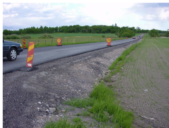
Figur 9. Förstärkningsarbete längs artrik väggkant.
